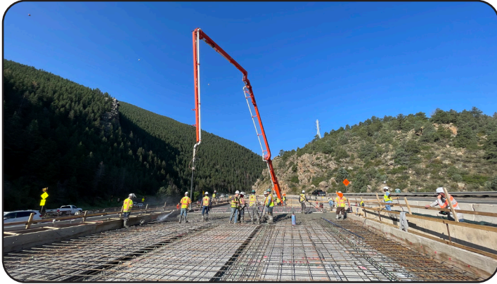
Image 23. Deck Pour of the Temporary Floyd Hill Bridge
