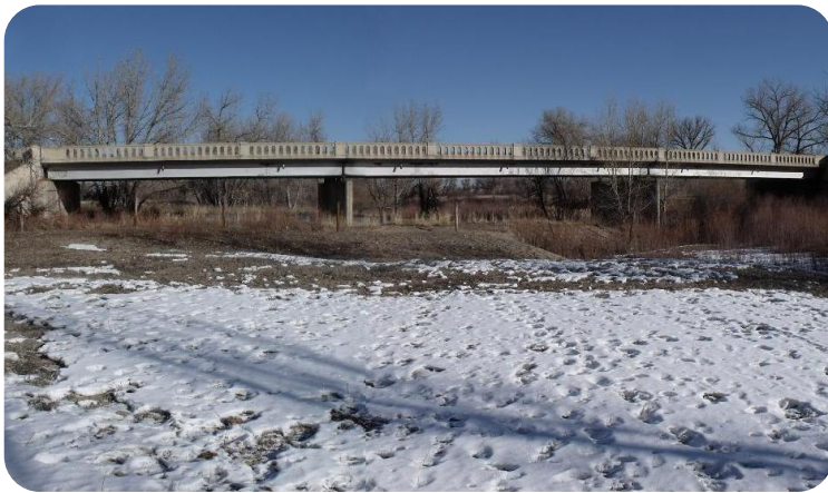
Image 8. SH 86 over Kiowa Creek (G-19-B)
