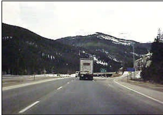
Maintenance strives for LOS A:
