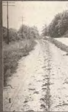
1—Earth road, 5.78 mi. per gallon. 2—Fair gravel road, 7.19 mi. per gallon. 3—Good gravel road, 9.39 mi. per gallon. 4—Bituminous macadam, 9.48 mi. per gallon. 5—Fair brick road, 9.88 per gallon. 6—Good brick road, 11.44 per gallon. 7—Concrete road, 11.78 per gallon.
