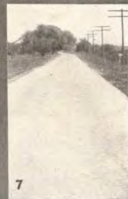
1—Earth road, 5.78 mi. per gallon. 2—Fair gravel road, 7.19 mi. per gallon. 3—Good gravel road, 9.39 mi. per gallon. 4—Bituminous macadam, 9.48 mi. per gallon. 5—Fair brick road, 9.88 per gallon. 6—Good brick road, 11.44 per gallon. 7—Concrete road, 11.78 per gallon.
