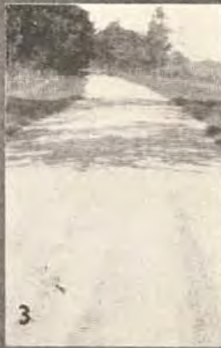
1—Earth road, 5.78 mi. per gallon. 2—Fair gravel road, 7.19 mi. per gallon. 3—Good gravel road, 9.39 mi. per gallon. 4—Bituminous macadam, 9.48 mi. per gallon. 5—Fair brick road, 9.88 per gallon. 6—Good brick road, 11.44 per gallon. 7—Concrete road, 11.78 per gallon.
