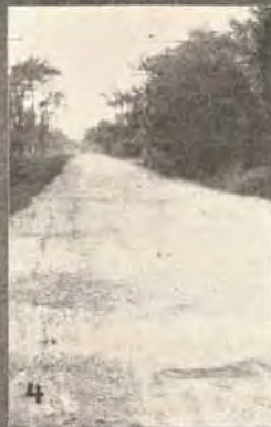
1—Earth road, 5.78 mi. per gallon. 2—Fair gravel road, 7.19 mi. per gallon. 3—Good gravel road, 9.39 mi. per gallon. 4—Bituminous macadam, 9.48 mi. per gallon. 5—Fair brick road, 9.88 per gallon. 6—Good brick road, 11.44 per gallon. 7—Concrete road, 11.78 per gallon.
