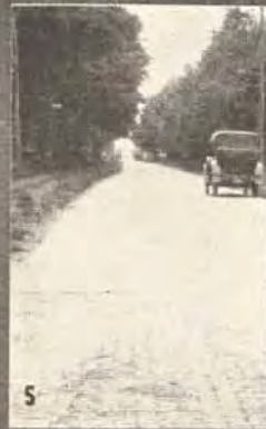
1—Earth road, 5.78 mi. per gallon. 2—Fair gravel road, 7.19 mi. per gallon. 3—Good gravel road, 9.39 mi. per gallon. 4—Bituminous macadam, 9.48 mi. per gallon. 5—Fair brick road, 9.88 per gallon. 6—Good brick road, 11.44 per gallon. 7—Concrete road, 11.78 per gallon.
